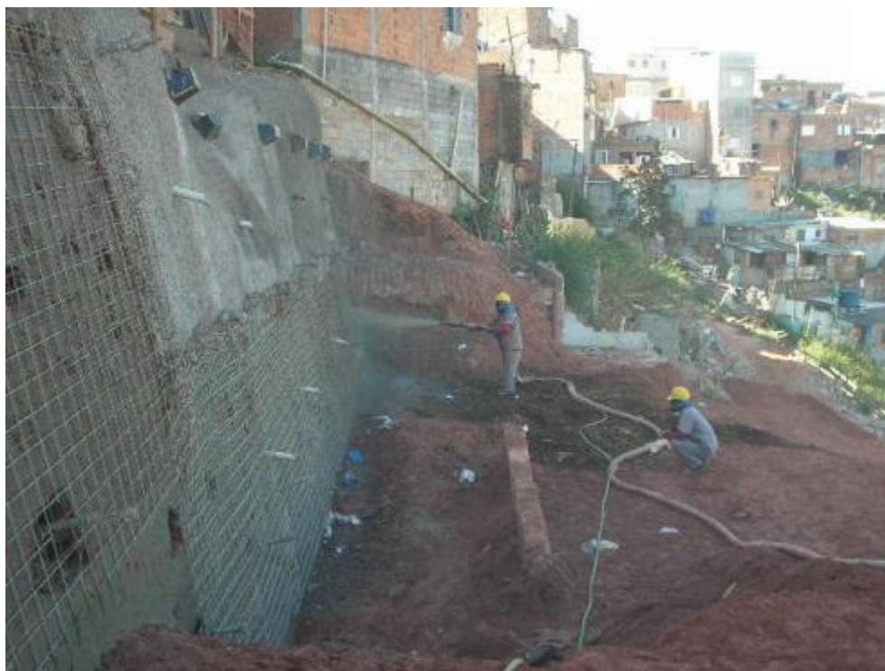
Figura 69 - - Execução do concreto projetado.
