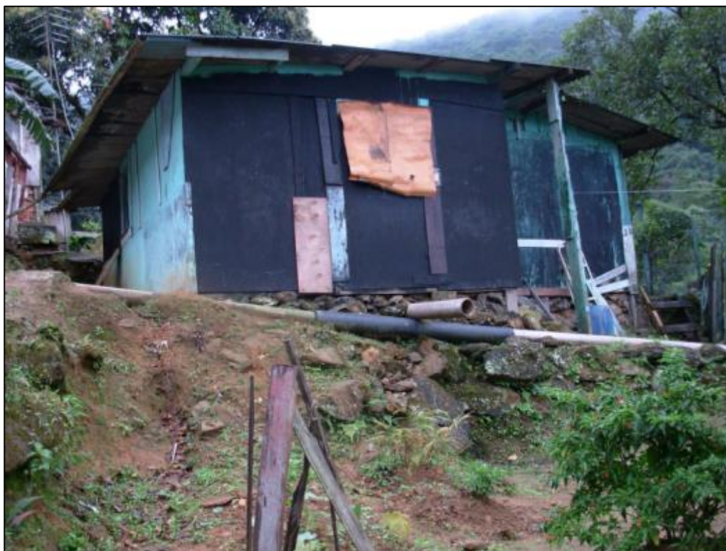
Figura 4 - Registro do IPT de uma moradia no Bairro Cota 400 feito na etapa de levantamento de áreas de risco em 2007. Observa-se o padrão construtivo existente na região, com moradia de madeirite, ocupando patamar de corte em talude com depósito de cobertura de cobertura detrítica recente de aterro. Além disso, pode-se notar a precariedade das instalações hidrossanitárias. (Fonte: IPT - RELATÓRIO TÉCNICO Nº 98.277-205 - ANÁLISE DE RISCOS AMBIENTAIS RELACIONADOS AO BAIRRO
